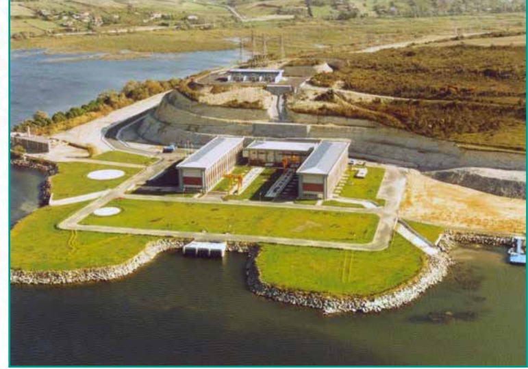
Fotoğraf 10: Terkos-İkitelli İçme Suyu İsale Hattı, Pompa İstasyonu ve Su Alma Yapıları
