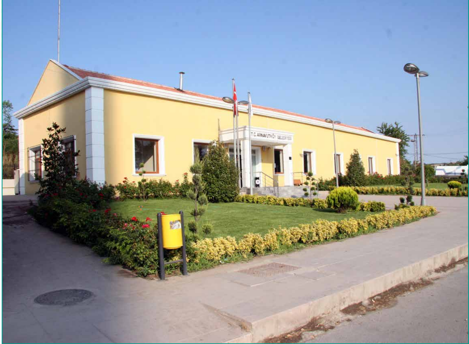
Fotoğraf 9: Durusu Hizmet Binası
