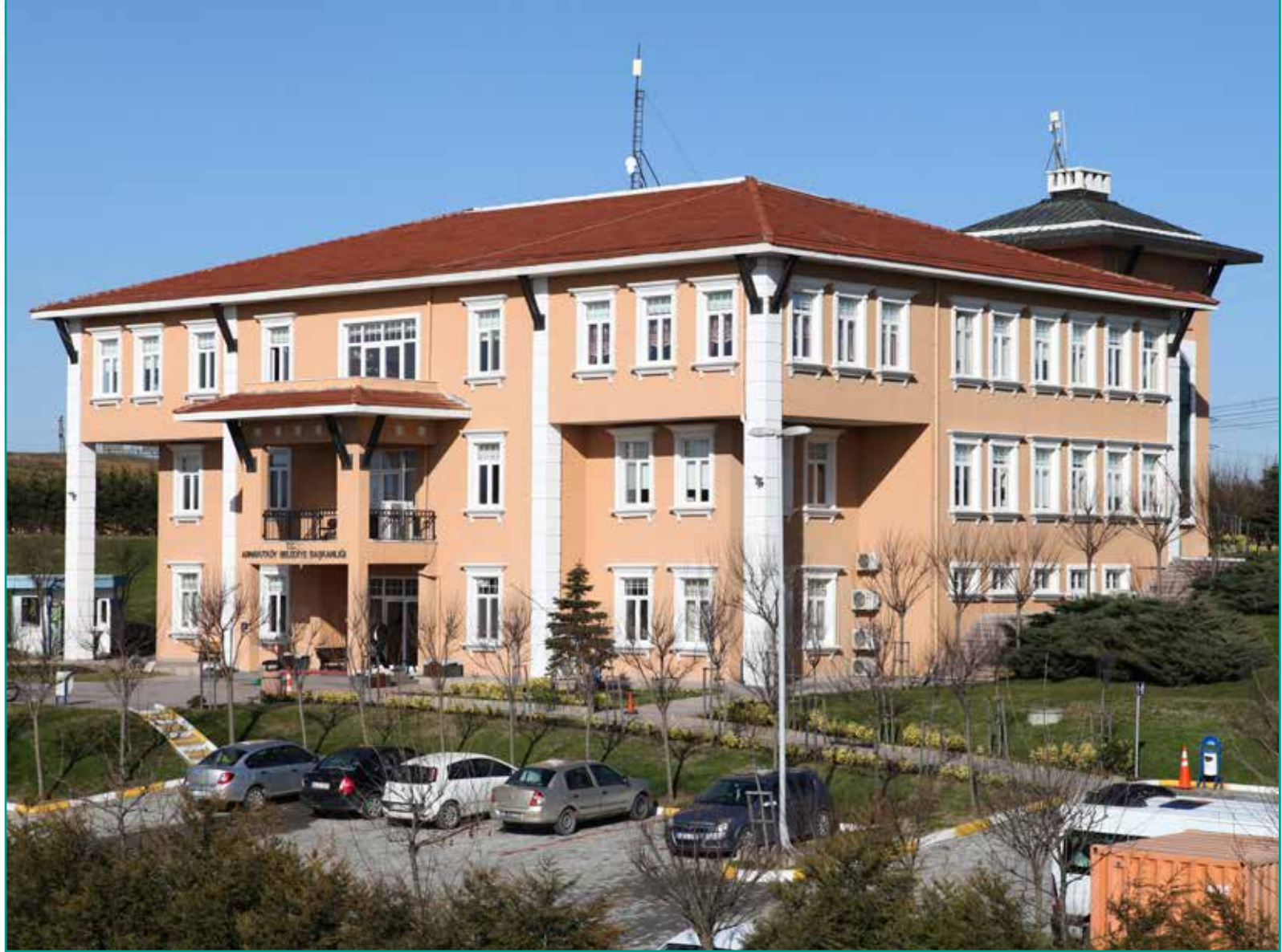
Fotoğraf 7: Taşoluk Hizmet Binası
