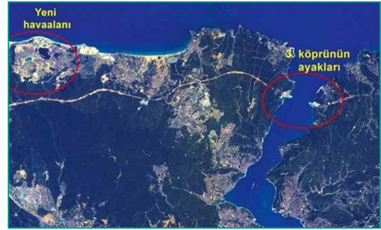
Fotoğraf 1: Yeni Havaalanı ve 3. Köprü İnşaatı
