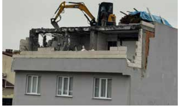
Kaçak Yapı Yıkımı, Taşoluk Mahallesi, 2025
