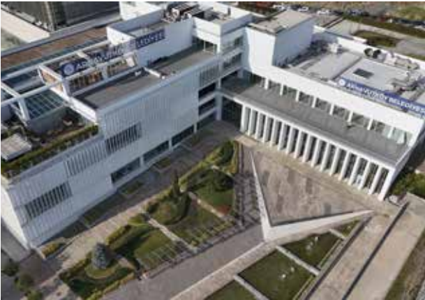
Arnavutköy Belediyesi Ana Hizmet ve Meclis Binası, 2025
