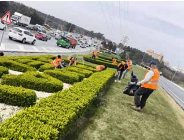
Fatih Caddesi Yeşil Alan Bakım Onarım Çalışması, 2025
