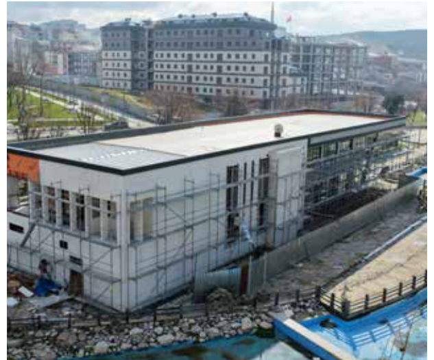
Vadipark Sosyal Tesisi İkmal İnşaatı, Mustafa Kemal Paşa Mahallesi, 2025
