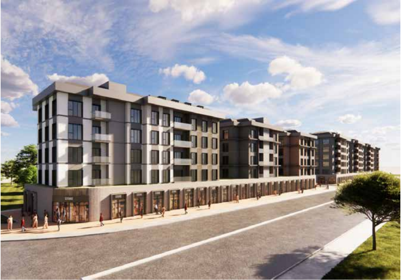
Yavuz Selim Mahallesi Konut İnşaatı, 2025
