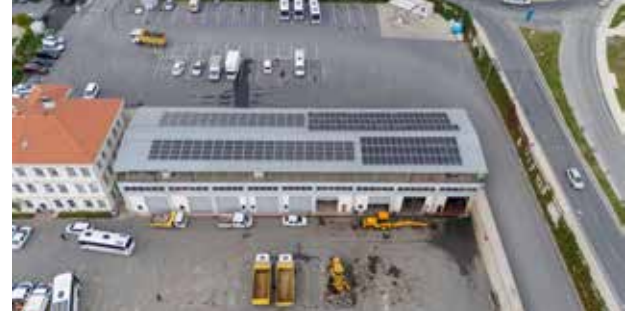
Afet Koordinasyon Merkezi Çatı GES Projesi, 2025
