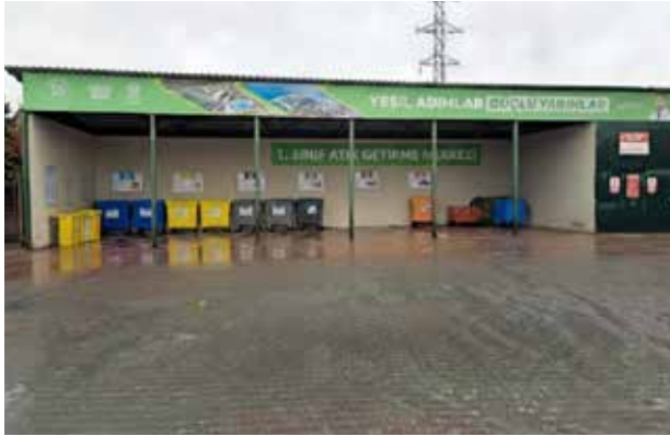
1. Sınıf Atık Getirme Merkezi, Arnavutköy Merkez Mahallesi, 2025
