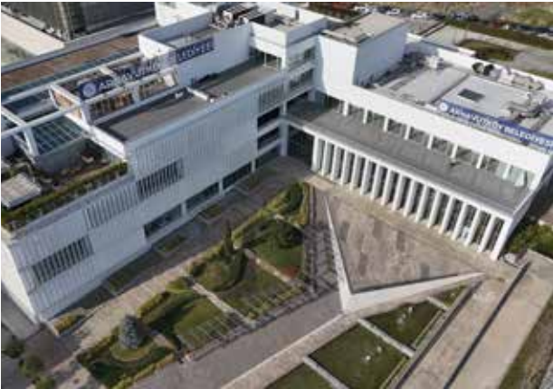
Arnavutköy Belediyesi Ana Hizmet ve Meclis Binası, 2025
