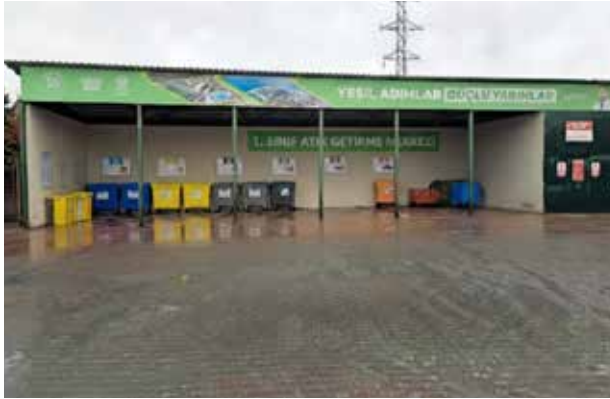
1. Sınıf Atık Getirme Merkezi, Arnavutköy Merkez Mahallesi, 2025
