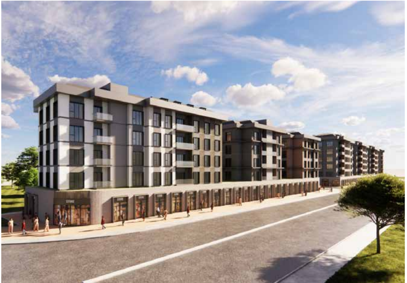
Yavuz Selim Mahallesi Konut İnşaatı, 2025
