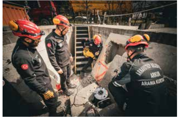
Enkaz İstasyonu Çalışmaları, Afet Eğitim Merkezi, 2025
