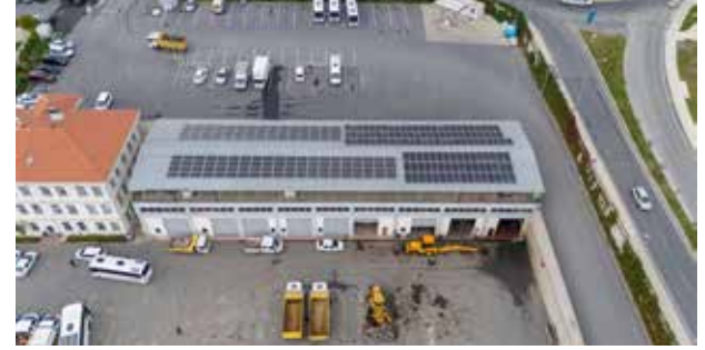
Afet Koordinasyon Merkezi Çatı GES Projesi, 2025
