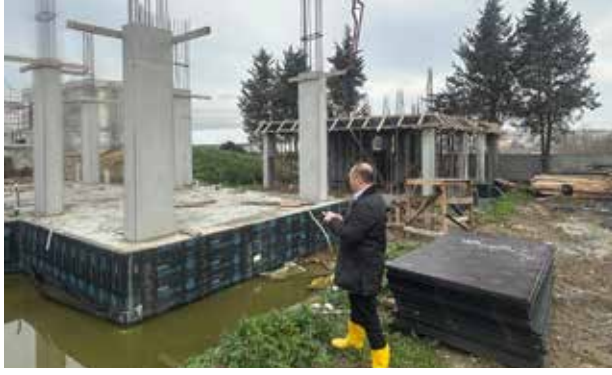
Yapı Denetim Çalışmaları, Haraççı Mahallesi, 2025
